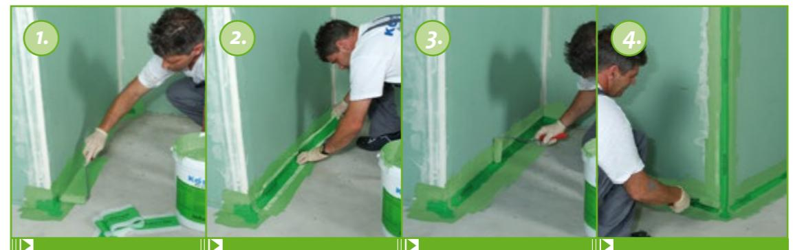
Aplicar uma camada de KÖSTER BD 50 na área onde o KÖSTER BD Flex Tape K 120 será instalado.
