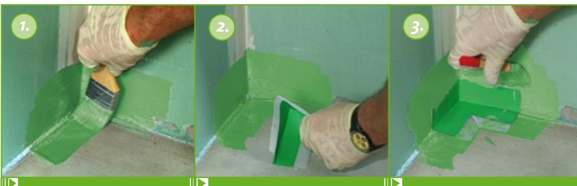
Aplicar uma camada de KÖSTER BD 50 na zona onde será instalado o KÖSTER BD Inside Corner aprox. 10 cm na parede e 10 cm no pavimento.
