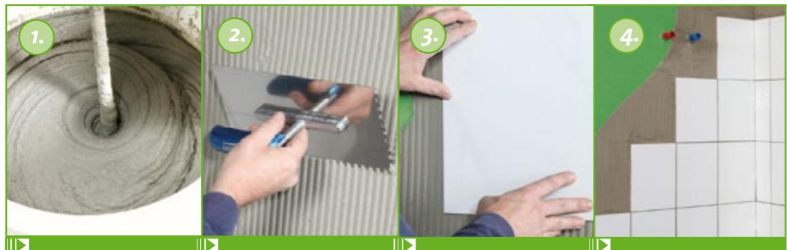
Colocar 6L de água num balde de mistura limpo e adicionar a massa em pequenas partes, mexendo continuamente com misturador eléctrico de baixa rotação.
