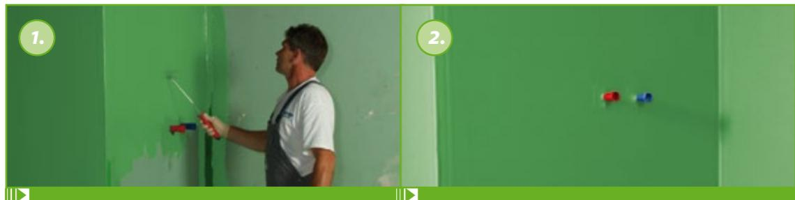
O KÖSTER BD 50 é aplicado em toda a área utilizando um rolo ou pincel. A aplicação de impermeabilização é sempre efectuada com recurso a 2 camadas. O consumo por camada é de 0,5 kg/m<sup>2</sup> com um total de 1 kg/m<sup>2</sup>. O intervalo de cura entre camadas é de 2 a 3 horas.
