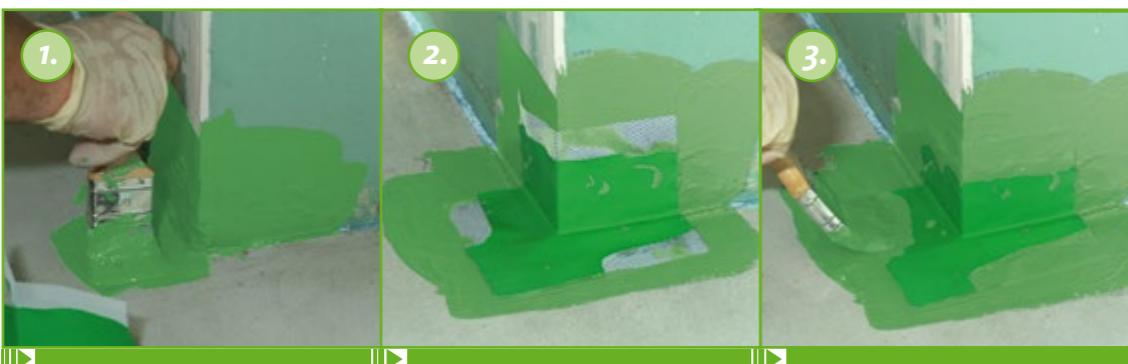
Aplicar uma camada de KÖSTER BD 50 na zona onde será instalado o KÖSTER BD Outside Corner aprox. 10 cm na parede e 10 cm no pavimento.
