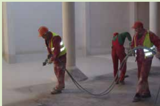
Reservatório de água potável, Tarnów, Poland
