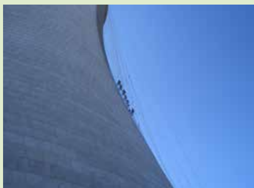
Torres de Arrefecimento, China
